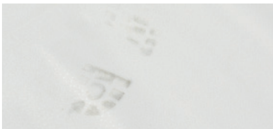
Impronte sul manto causate dalla messa in opera.
