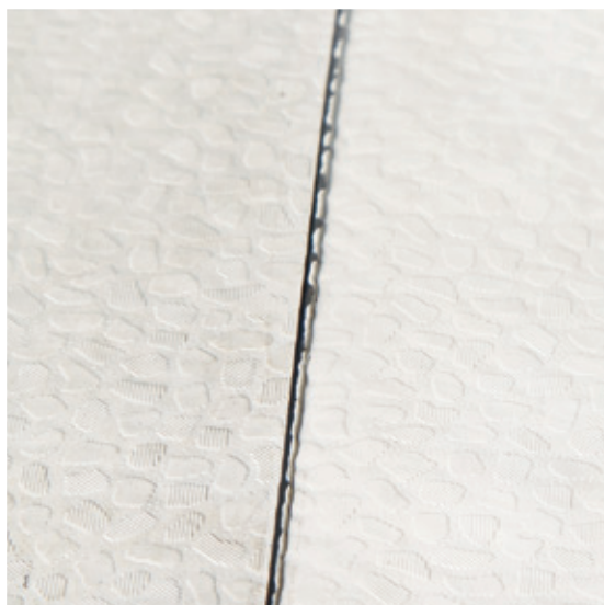
Membrana con sottofondo di colore scuro, la saldatura è distinguibile.
